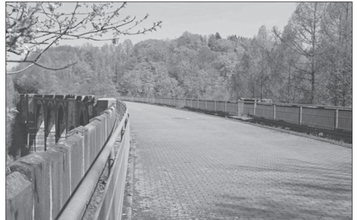
Der Zustand der Brückenkrone zwischen 2010 und 2018. Gut erkennbar das Pflaster mit Betonformsteinen und das Sicherungsgeländer innerhalb der Brüstung.
